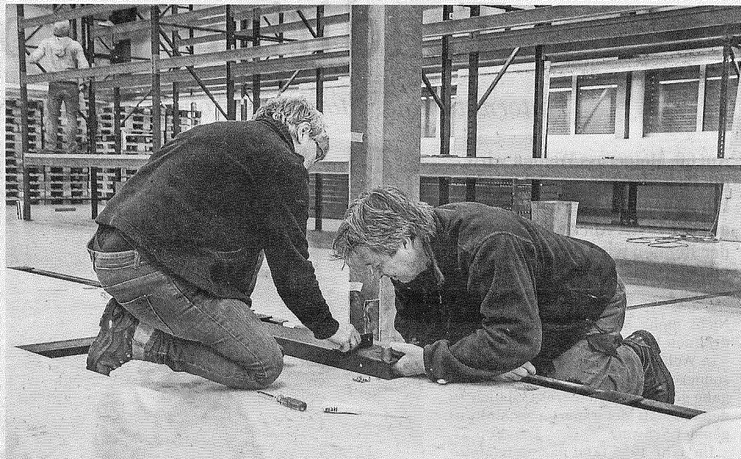
Jeden Samstag sind Bühnenchef Stefan Hegi (rechts) und sein Team in der Halle am Schuften. Nach und nach verwandelt sich die kalte Lagerhalle in einen gemütlichen Raum.
